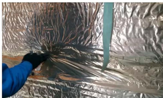
Figure 35 : adhésif marouflé sur l'isolant
